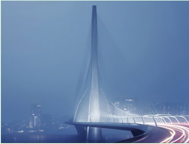
圖 9：淡江大橋，引自交通部公路局
