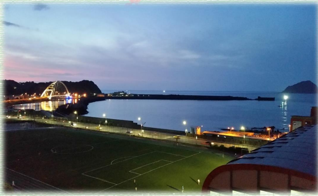
基隆中心前和平島橋
